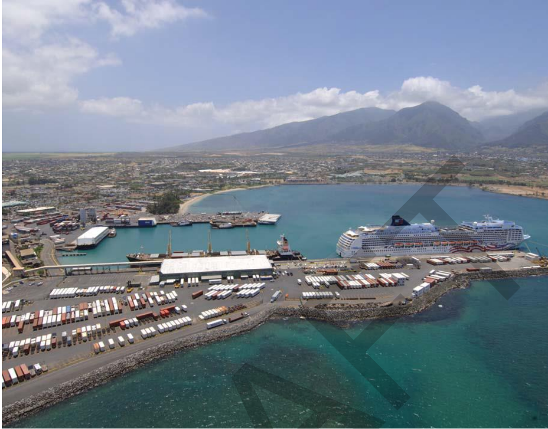
Kahului Harbor (DoT photo)
